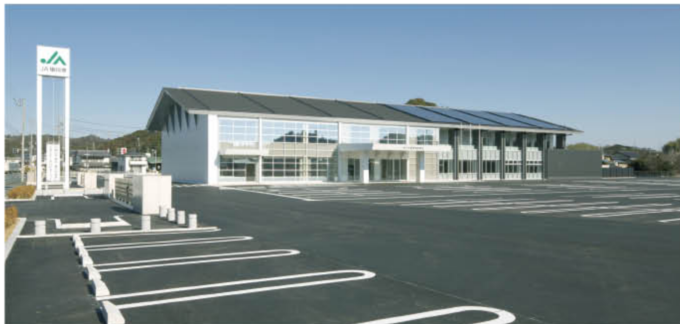
本会の設計施工監理による農協本所の建設
