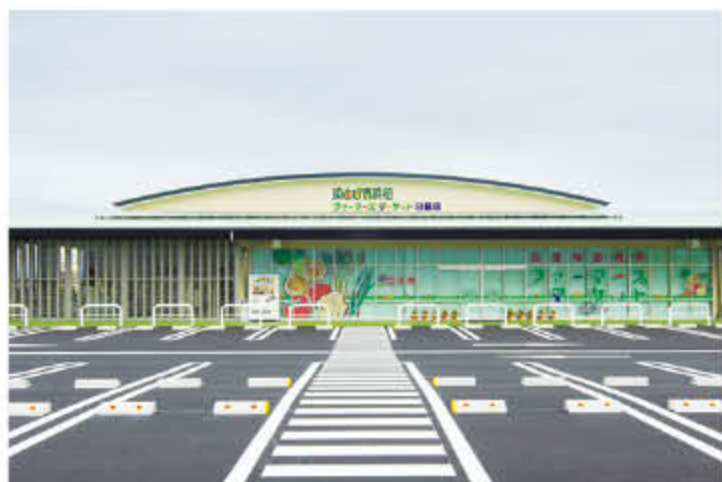
ファーマーズマーケットの建設
