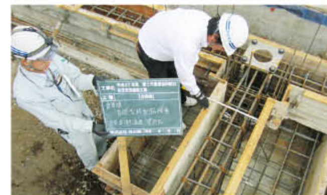
基礎配筋検査
